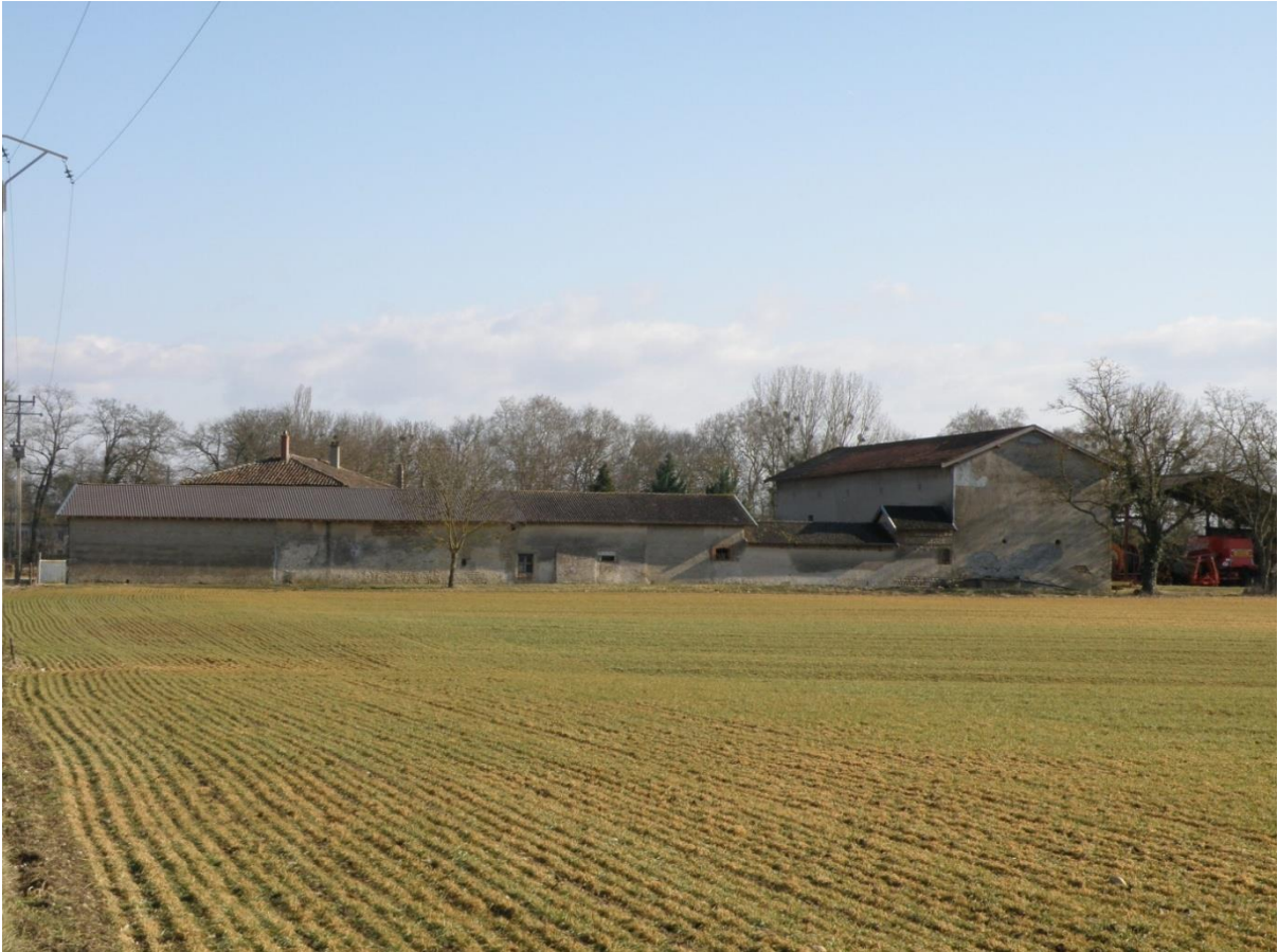
A. Ensemble bâti de la Grange Cochet
